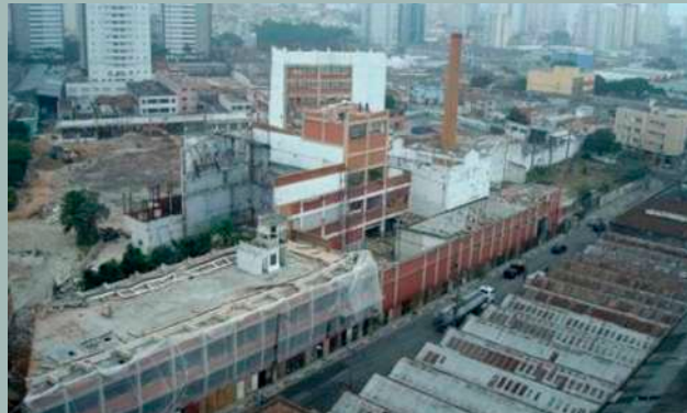
Foto fabrica União antes de ser demolida Fonte: http://www.vitruvius.com.br
